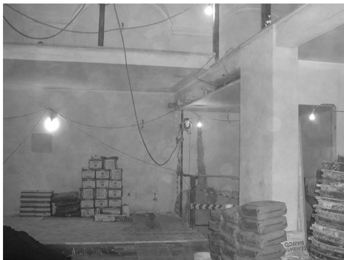
Immagini del salone con le piastrelle da posare del nuovo centro diurno in via di ultimazione. Verrà aperto prevedibilmente in ottobre.
