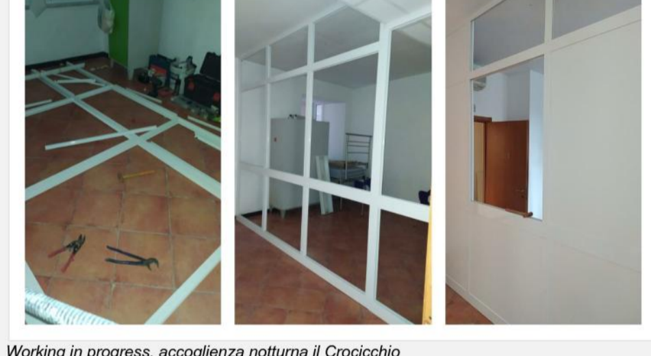
Working in progress, accoglienza notturna il Crocicchio
