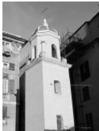
Il campanile, ora nuovamente con la croce, appena liberato dai ponteggi
